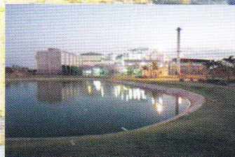
โรงไฟฟ้าชีวมวลโดยใช้เทคโนโลยีกังหันไอน้ำ ขนาด 8.8 MW ของบริษัท รอยเอ็ด กรีน จำกัด Roi-Et Green Co., Ltd's 8.8-MW Biomass Power Plant using Steam Turbine
